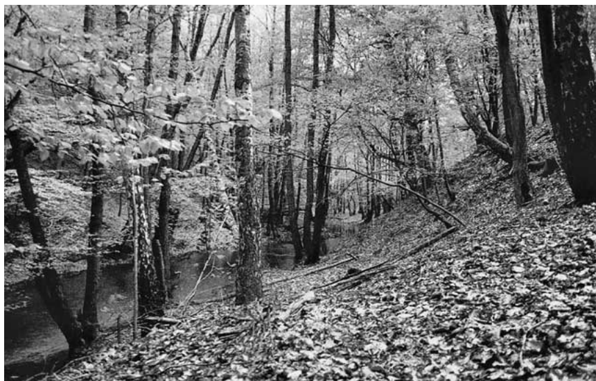
Bild 3: Teil der Scheitelhaltung des Verbindungskanals Schweriner See - Ostsee, die bis zu 10 m tief in die Hügel am nördlichen Seeufer eingegraben wurde [8]
